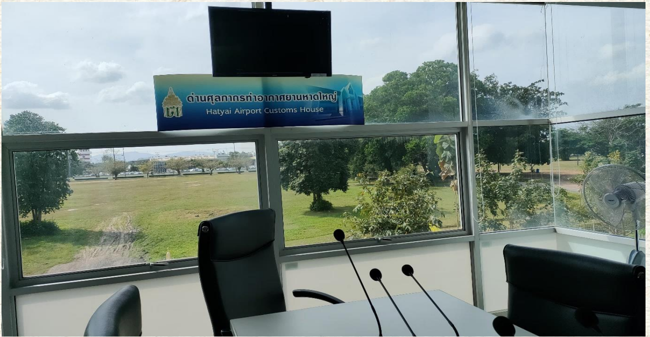
ก่อนติดตั้ง
